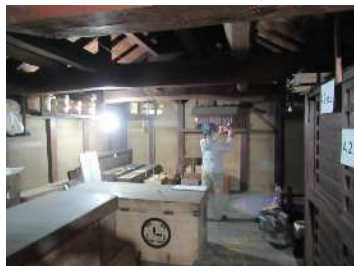
「土蔵」内部の計測
