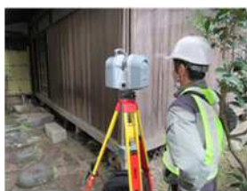
レーザーによる建物測量
