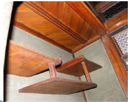
2階座敷の二見棚と矢羽張りの天井
