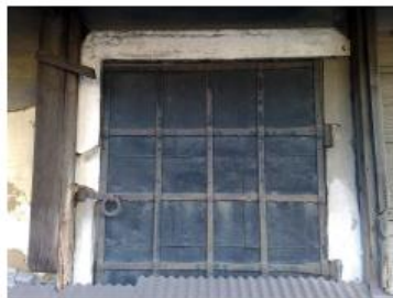
2階東側の窓、片開きの鉄扉
