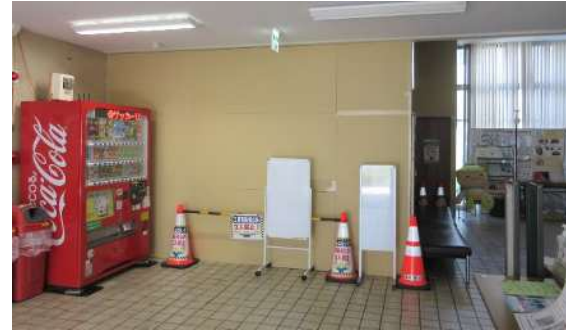
▲2階への階段は工事区画内になり通行不可となっています
