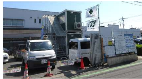
▲正面駐車場半分はプレハブが設営され工事車両が入ります
