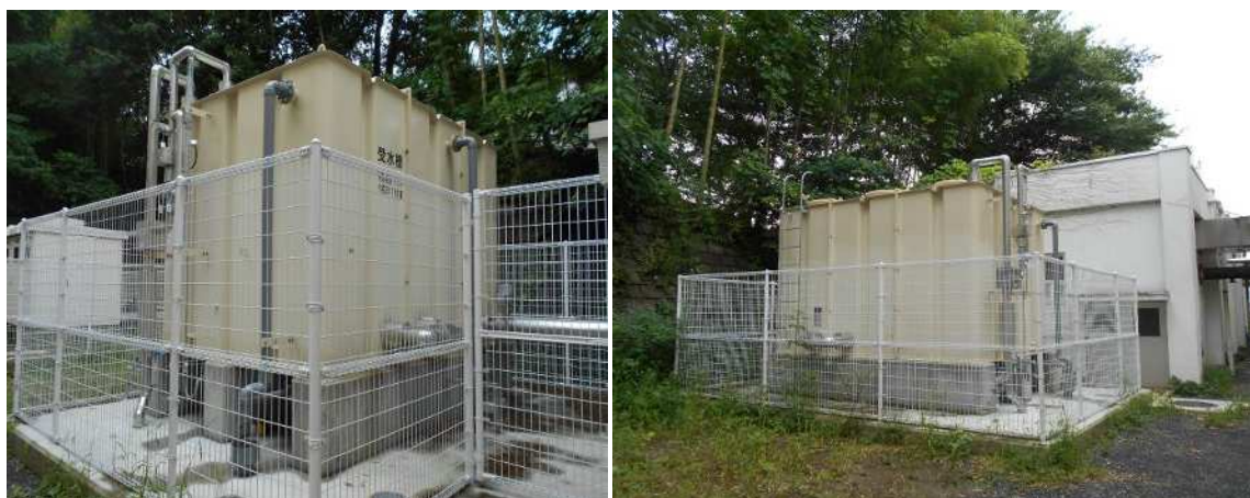
受水槽改修工事（山口中学校）
