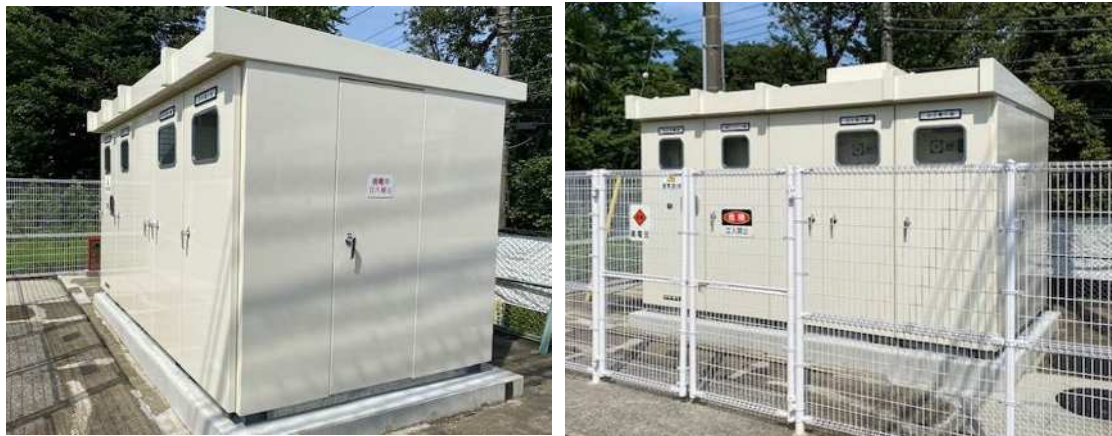
受変電設備改修工事（明峰小学校）
