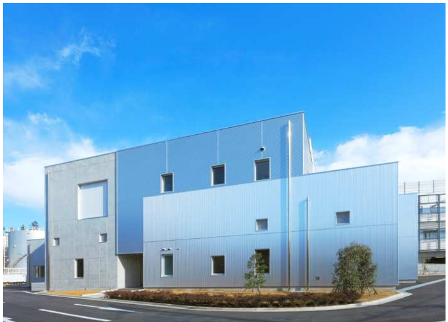
所沢市衛生センター
