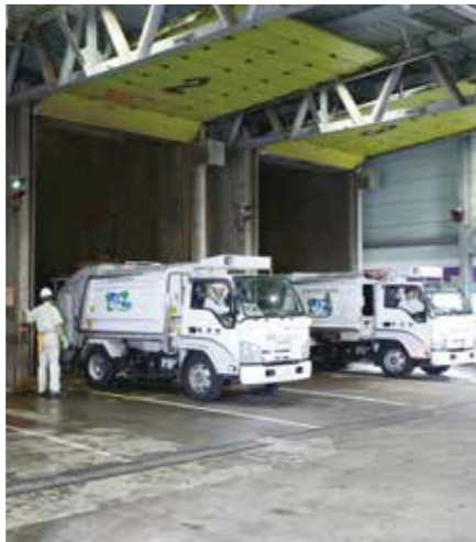
プラットホーム ごみ収集車等で集められたごみをごみピットへ投入する場所で、投入扉が3箇所あります。
