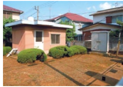
①取水井 (深さ240m~350m) 浄水場のまわりの深井戸からポンプで地下水をくみ上げる。
