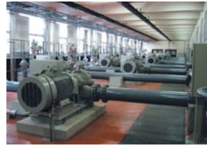
⑤配水ポンプ ポンプで市内の家庭や学校に水を送る。
