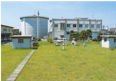
第一浄水場 宮本町二丁目7番7号
