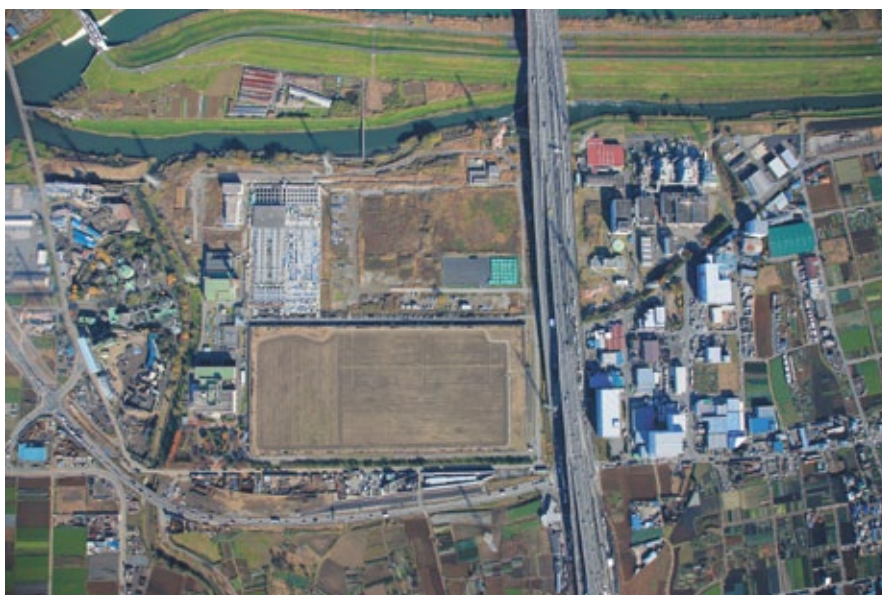
新河岸川水循環センター（和光市）
