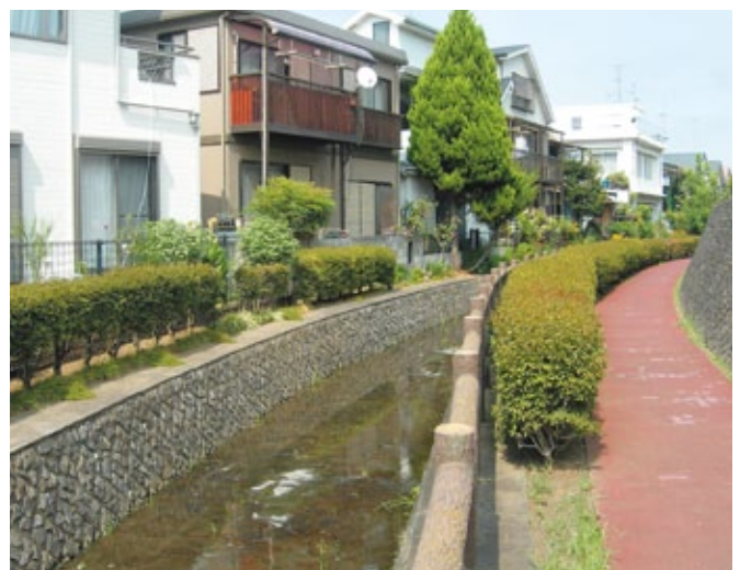
せせらぎ水路
