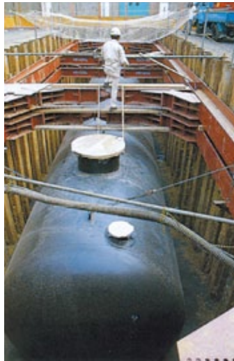
耐震性貯水槽の工事の様子
