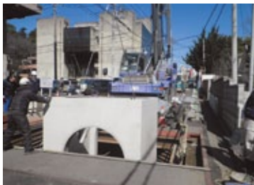
マンホール耐震工事の様子
