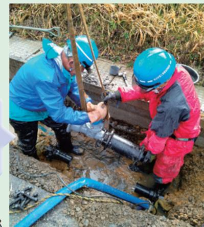
▲ 輪島市で所沢市管工事業協同組合と協力して破損した管の応急復旧活動を行っている様子
