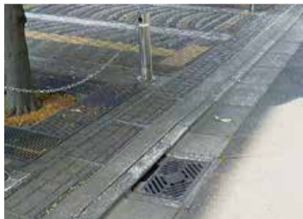
雨水ますとは… 道路等に降った雨を集めて地下に浸透させたり、下水管へ排水する役割を持っています。
