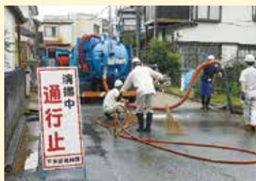
下水管清掃の様子
