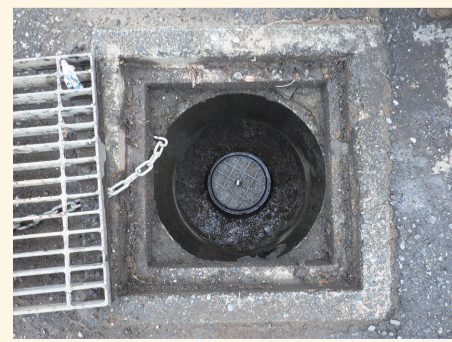
▲降った雨を集め、地下に浸透させる改良工事後の雨水樹
