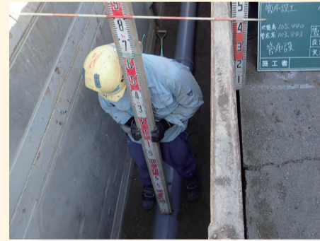
▲下水道管の布設工事
