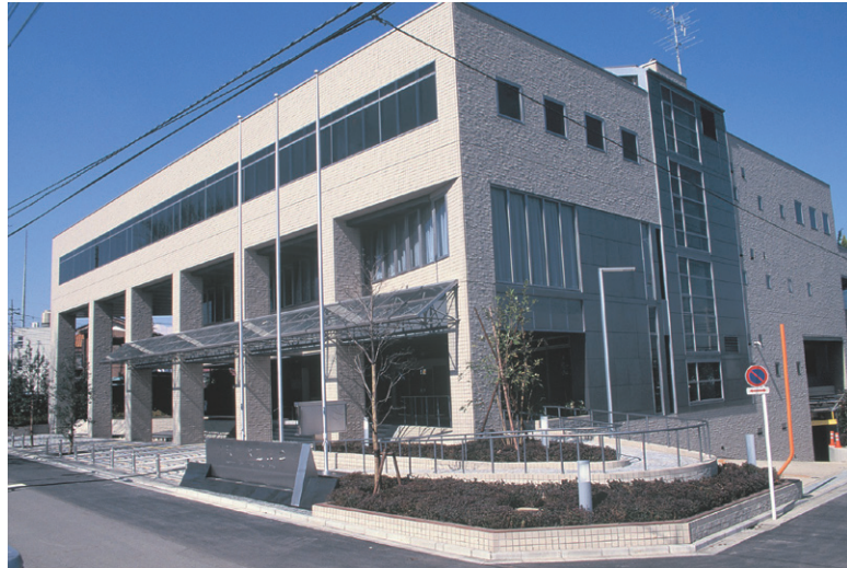
所沢市上下水道局庁舎
