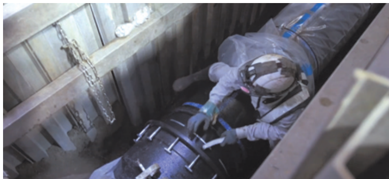
水道管の布設替えの工事の様子
