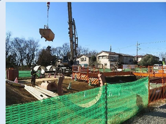
雨水推進工事を進めています。
