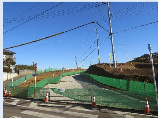
区 11.5-1 号線の道路整備を進めています。
