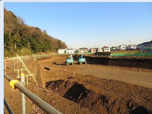
調整池工事が進んでいます。
