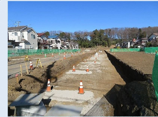
区 6-19 号線のインフラ整備を進めています。
