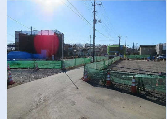
整備した宅地に家が建ち始めました。
