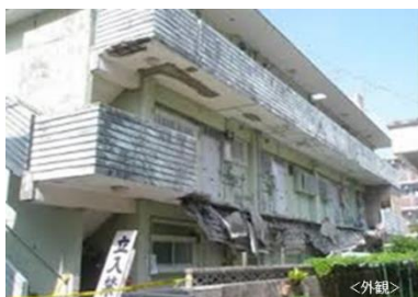
マンションの2階廊下が崩落した事例
