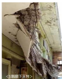
マンションの2階廊下が崩落した事例
