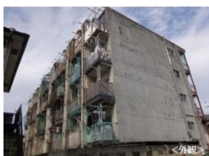
建物の痛みが激しく外壁の剥落、鉄骨の露出などが見られる事例
