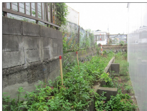
ブロック塀等が境界を越えていないか確認します。
