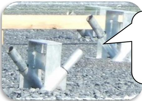
FXT鋼管基礎です。クロスして打ち込まれているのがわかります。
