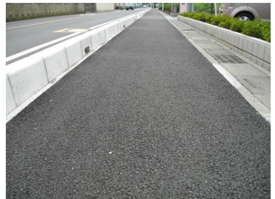
■透水性舗装の歩道
