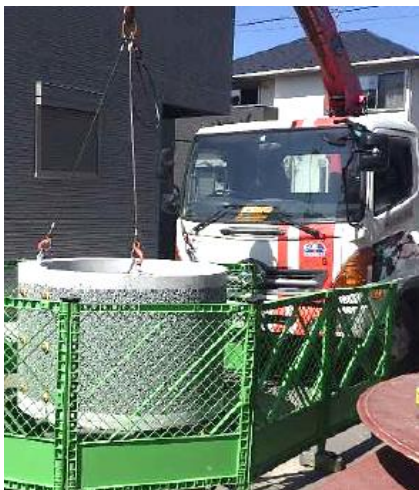
■ 雨水浸透井築造工事
