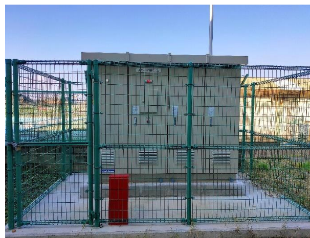
向陽中学校の自家消費型太陽光発電設備と大型蓄電池
