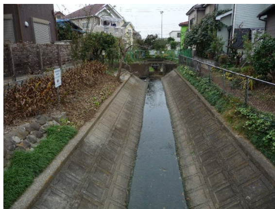
水量が少ない時は、水は上林川方面に左折し、 林川（直進）には流れない
