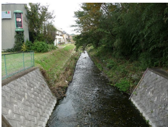
多自然型護岸に改修されている
