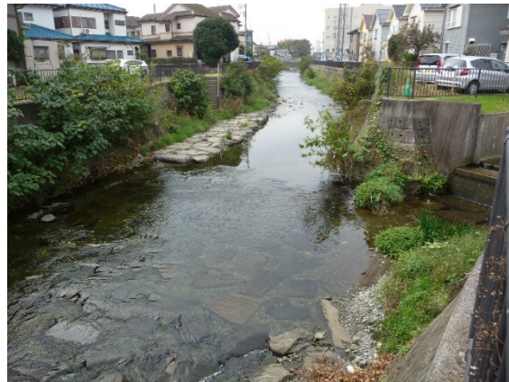
河床には礫や土砂が堆積している
