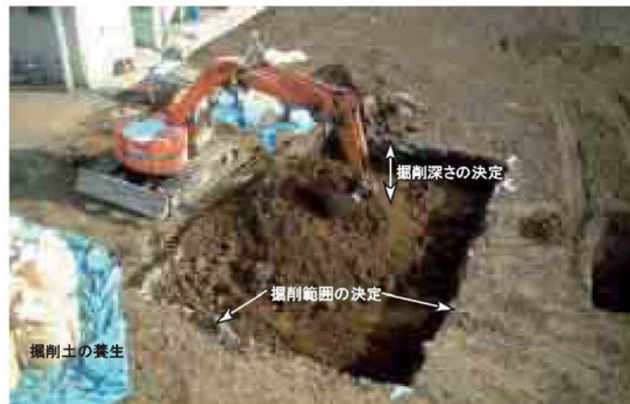
図 8-14 掘削除去の概況写真
