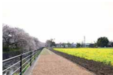
遊歩道の整備
