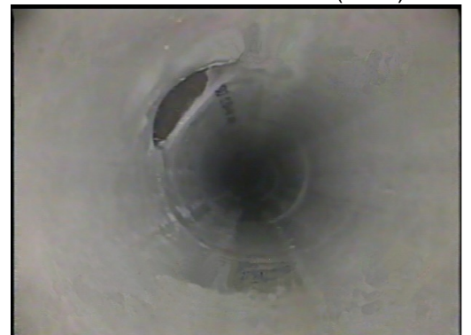
更生工事施工後の管渠(参考)
