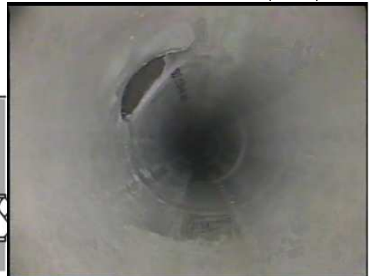
更生工事施工後の管渠(参考)
