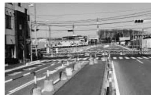
▲東京狭山線・東川橋りょう工事付近
