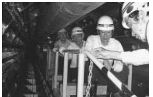
▲雨水管内をトロックで視察(北秋津)
