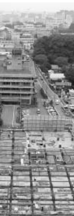
旧市庁舎(奥)と工事中の元町北地区再開発事業
