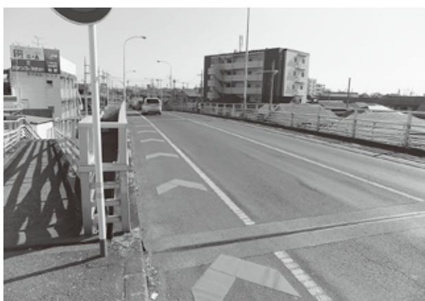
▲所沢陸橋の路側帯 (写真中央)
