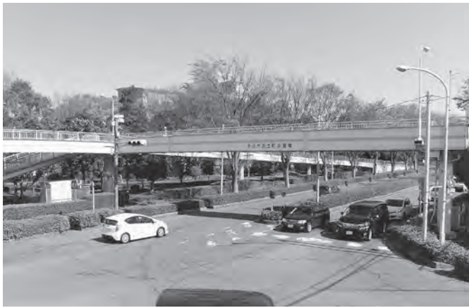
▲弥生町歩道橋
