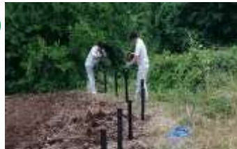
職員による柵・看板の設置
