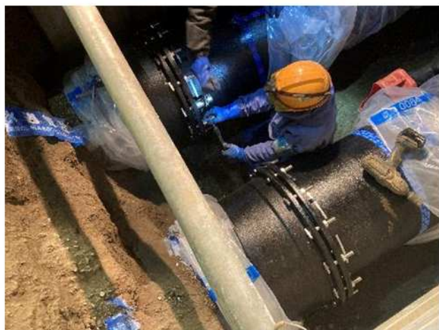
工事名 所沢地区配水管更新第1号工事 1-①路線DIP.NSφ700布設工 工事完了 GL-1500 OF=
