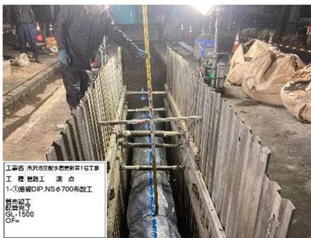
工事名 所沢地区配水管更新第1号工事 1-①路線DIP.NSφ700布設工 工事完了 GL-1500 OF=
