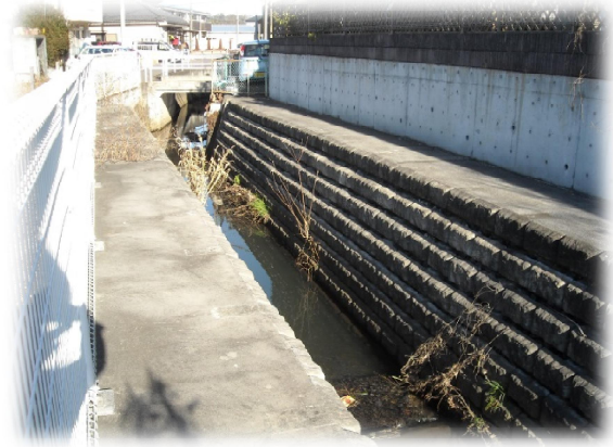
上山口地内水路整備工事
