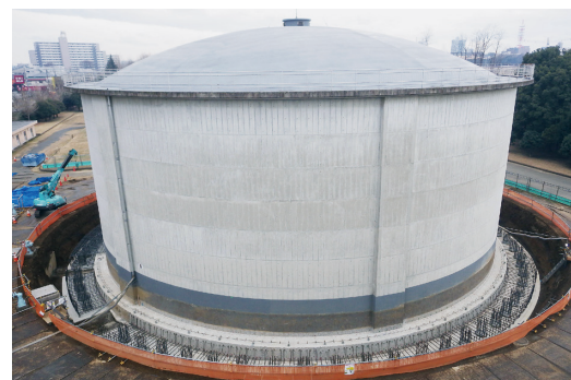
耐震補強工事（東部浄水場）
