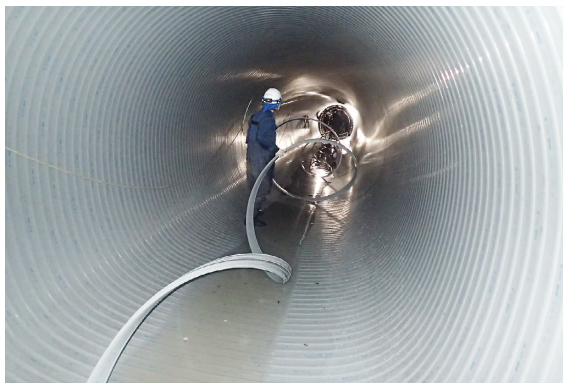
下水道管の更生工事
