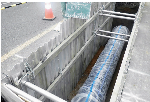
水道管布設工事
