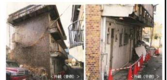
外壁、手すりが崩落した事例
