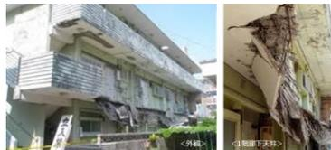
マンションの2階廊下部分が崩落した事例
