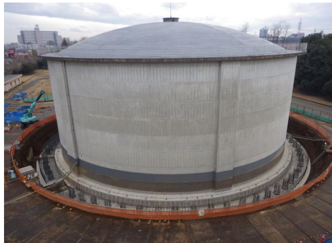
東部浄水場4号配水池耐震補強工事
