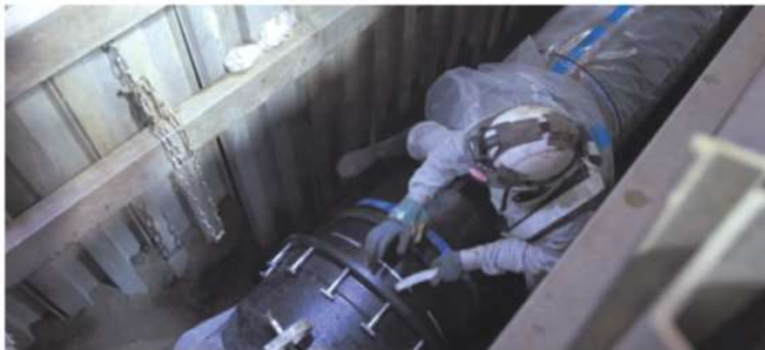
水道管の布設替えの工事の様子
