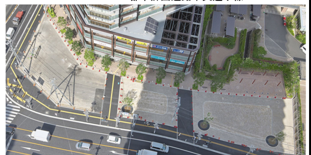
所沢東町地区第一種市街地再開発事業 公共施設工事(令和 5 年 3 月竣工) 都市計画道路中央通り線
