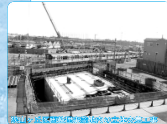
狭山ヶ丘地区区画整理事業地区内の立体交差道路工事
