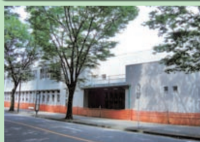
現在建設中の新所沢地区複合施設
