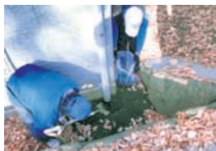
▲除染作業の様子
